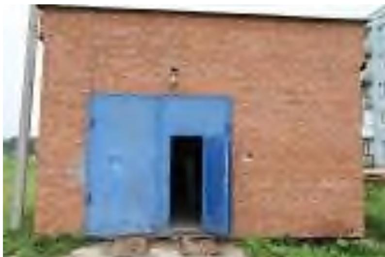
ЦТП системы теплоснабжения п. Есинка расположен в отдельно стоящем капитальном одноэтажном строении. Стены здания выполнены из пустотелого красного кирпича, кровля - металлическая. Пол оборудован цементной стяжкой. В помещении ЦТП размещается узел подготовки горячей воды. Подготовка осуществляется посредством использования теплообменного аппарата, состоящего из теплопередающего элемента и полостей для движения теплоносителя. Горячее водоснабжение осуществляется по закрытой схеме.
